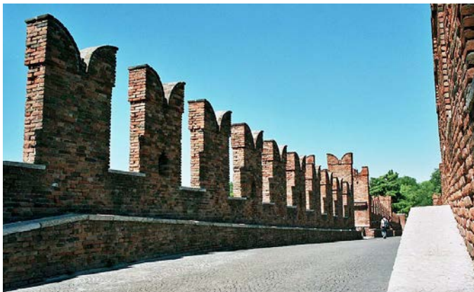
Рис. 26. Зубцы «ласточкин хвост»
