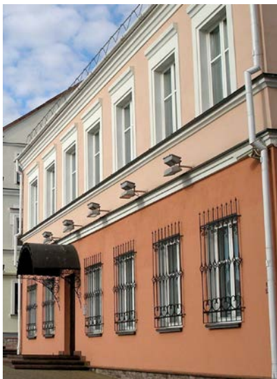
Рис. 47. Здание в Троицком предместье в Минске с двумя поясками между этажами
