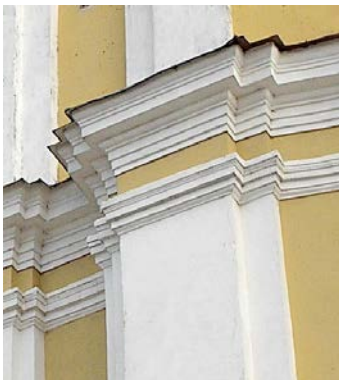
Рис. 48. Раскреповка на фасаде церкви Воздвижения Святого Креста в Лиде
